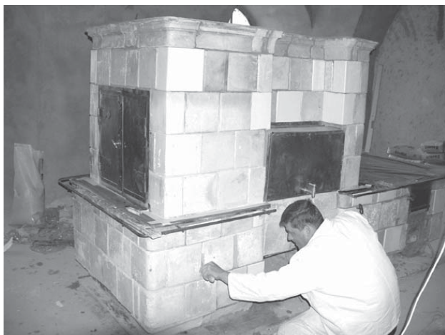
Radovi na rekonstrukciji kuhinjske peći
