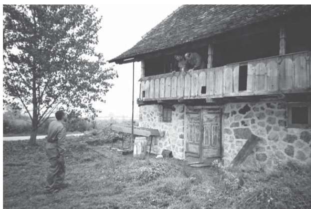
Obnova ganjka i pristupnog stubišta na objektu prenesenom u etnonaselje iz Malog Erjavca
