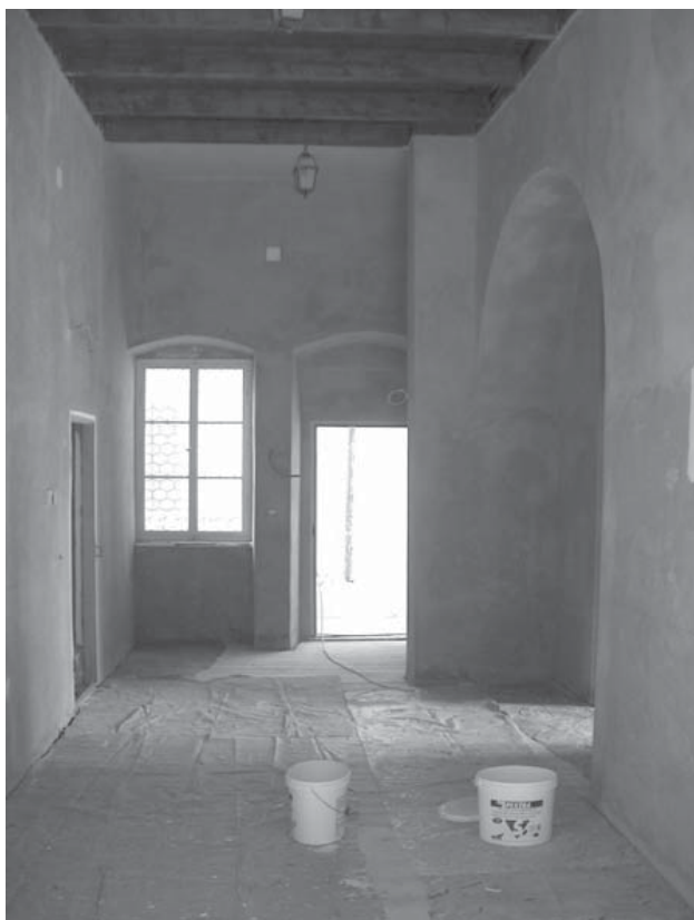
Završni građevinsko-obrtnički radovi na novom stalnom postavu
