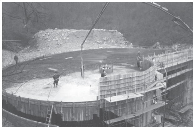
Radovi na izgradnji novog Muzeja krapinskih neandertalaca
