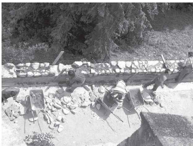
Radovi na sanaciji bedema
