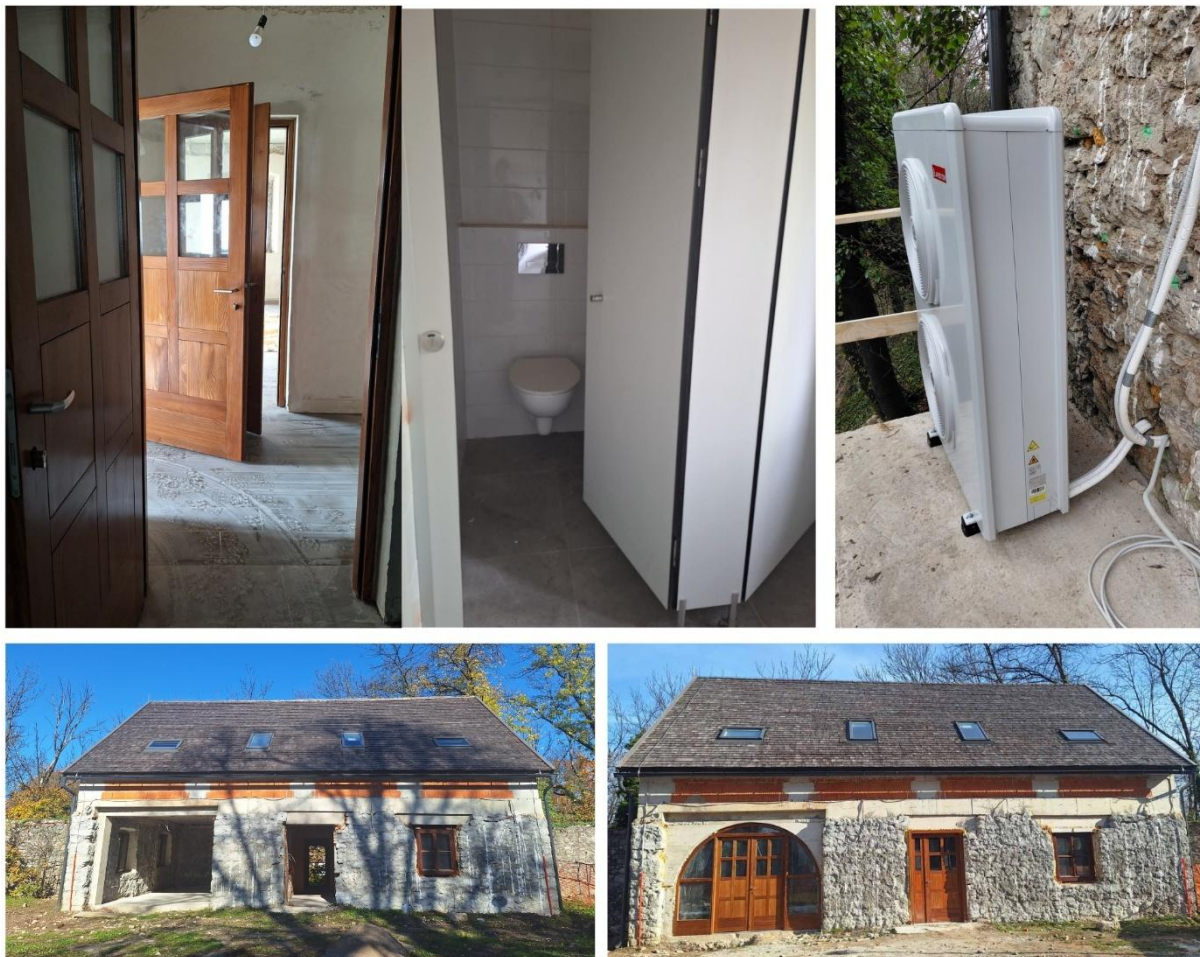
Obnova dvorišne zgrade konjušnice u Starom gradu Ogulinu – radovi u 2025. godini. Autor fotografija: Ana Krznarić
