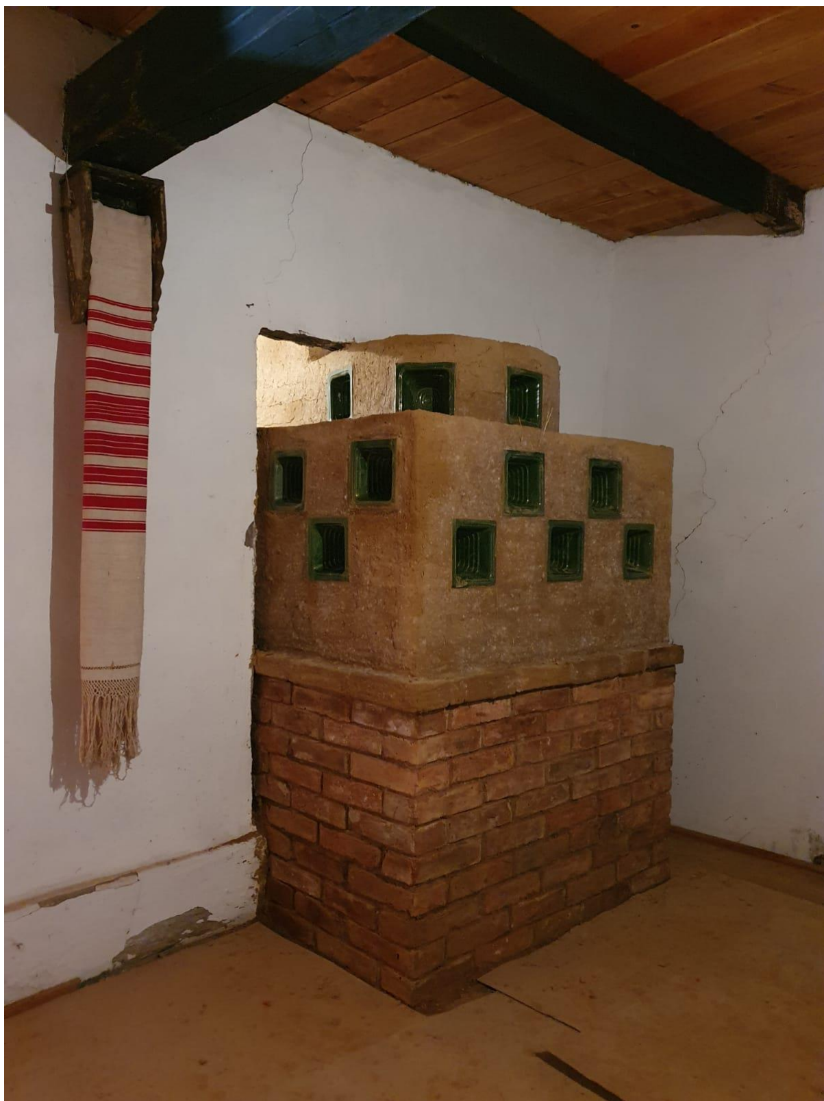
Slika 22. Nova peć – Etno kuća Šćitarjevo
