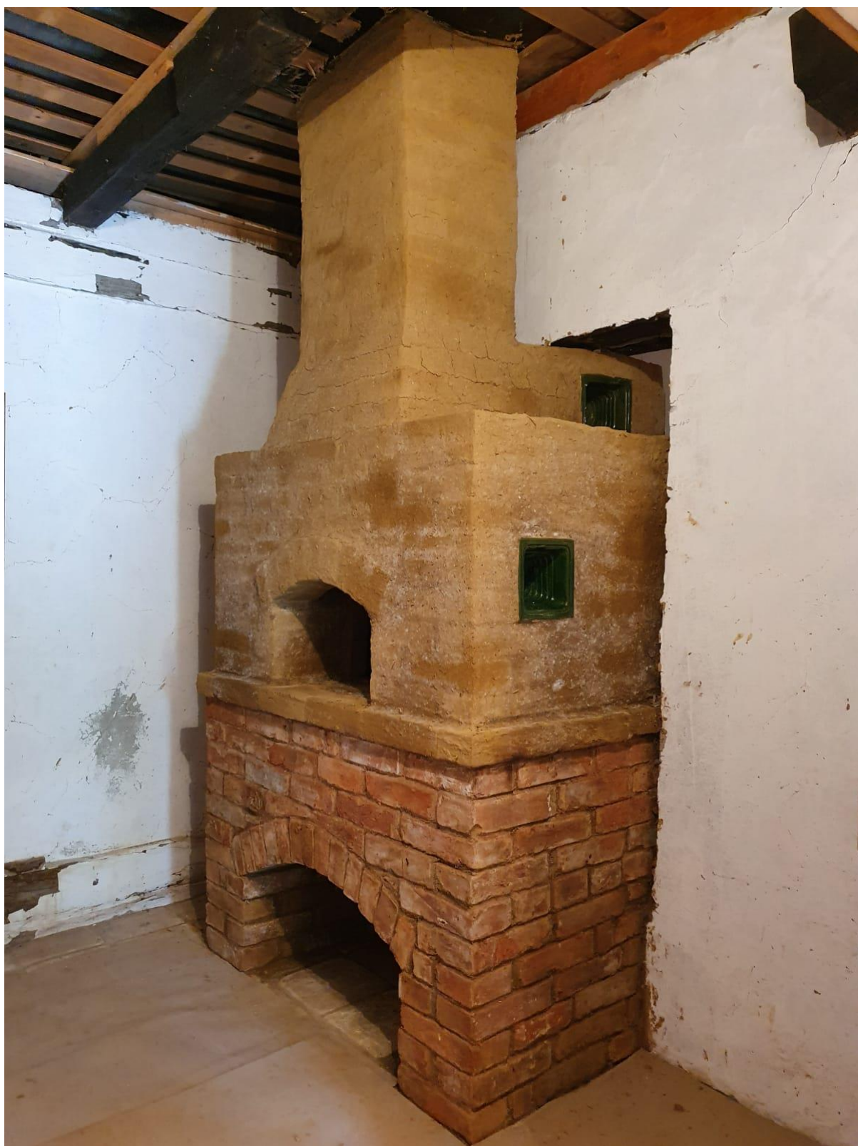
Slika 21. Nova peć – Etno kuća Šćitarjevo
