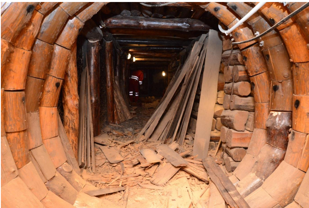
Radovi sanacije Rudnika
