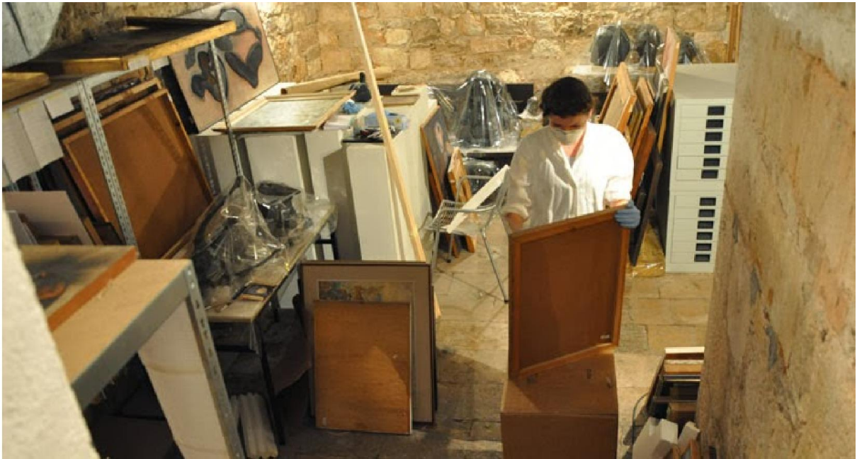
Uređenje privremenog galerijskog depoa - Tijek radova (3)
