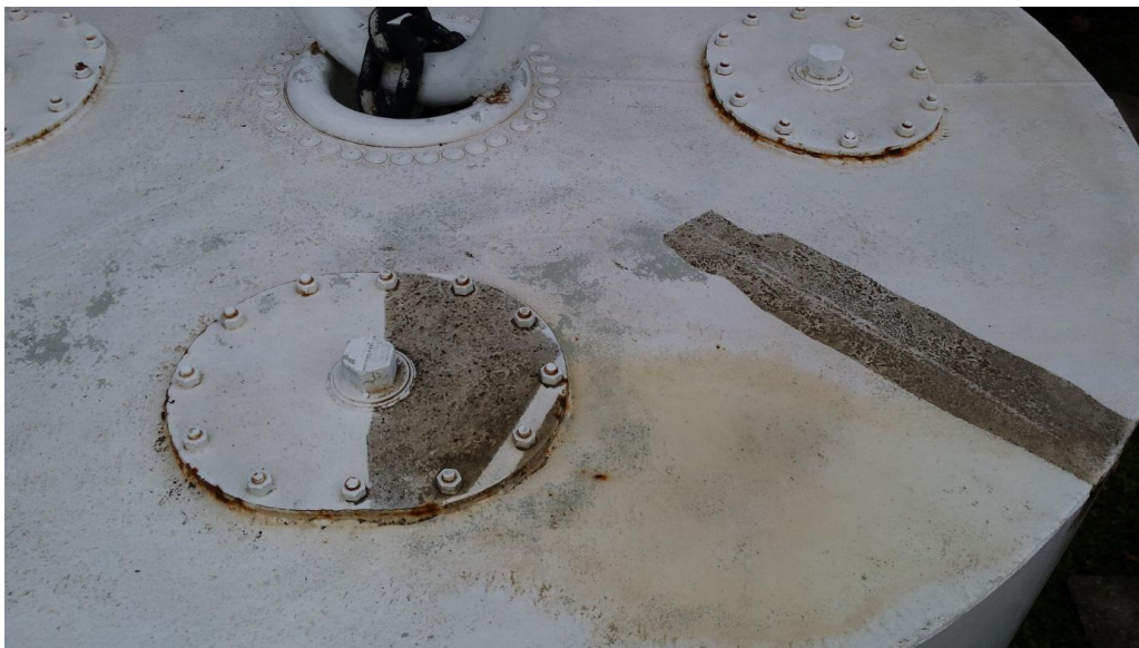
Detalj čišćenja plutače - vidljive su naslage nečistoće nakon čišćenja
