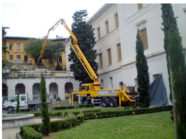
Radovi na terasi iznad Lapidarija
