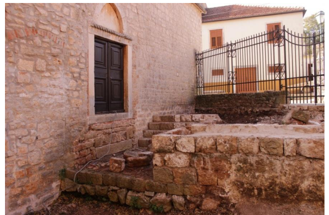
Sl. 2. Konzervatorski radovi na otvaranju sjevernog ulaza u crkvu sv. Ivana
