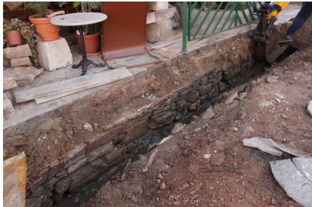
Sl. 5. Pogled na stijenke starog kanala građene u suhozidnoj tehnici.
